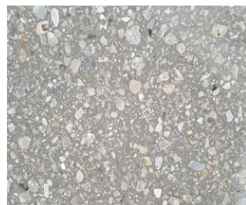
Необходимо помнить, что механическая подготовка основания применяется НЕ ТОЛЬКО для удаления загрязнений и открытия пор, но и для увеличения адгезии с покрытием. Чем более текстурированная поверхность получается в результате обработки, тем выше адгезия покрытия, и, следовательно, выше его стойкость к динамическим нагрузкам и дольше срок эксплуатации.
