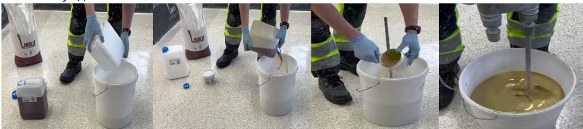
2. Постепенно вносить наполнитель (компонент С) в смесь компонентов, мешать в течение минимум 2 минут до полного перемешивания и получения гомогенной (однородной) смеси. Рекомендуемое время смешивания: 2-3 минут.
